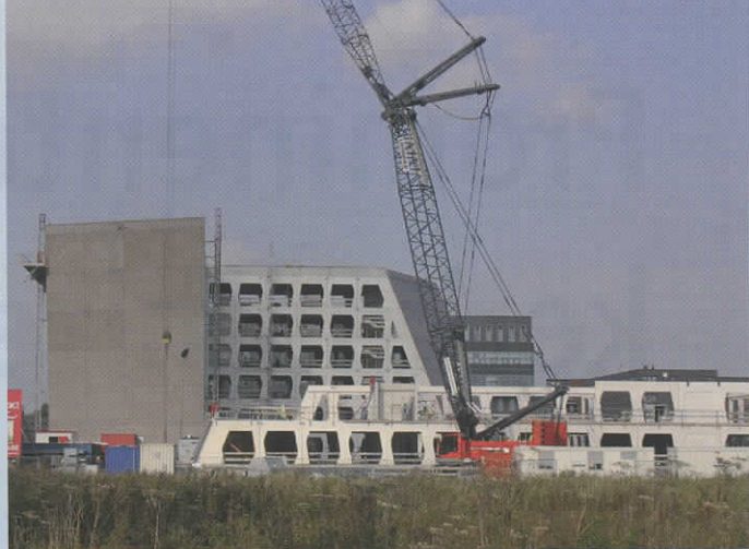
Naast gebouw 1 is begonnen met het tweede kantoorvolume
