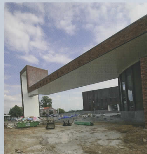
Voorpleingevel met koperafwerking
